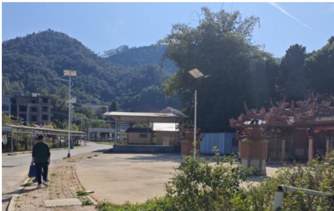
图 3-7 库湾路戏台现场照片
