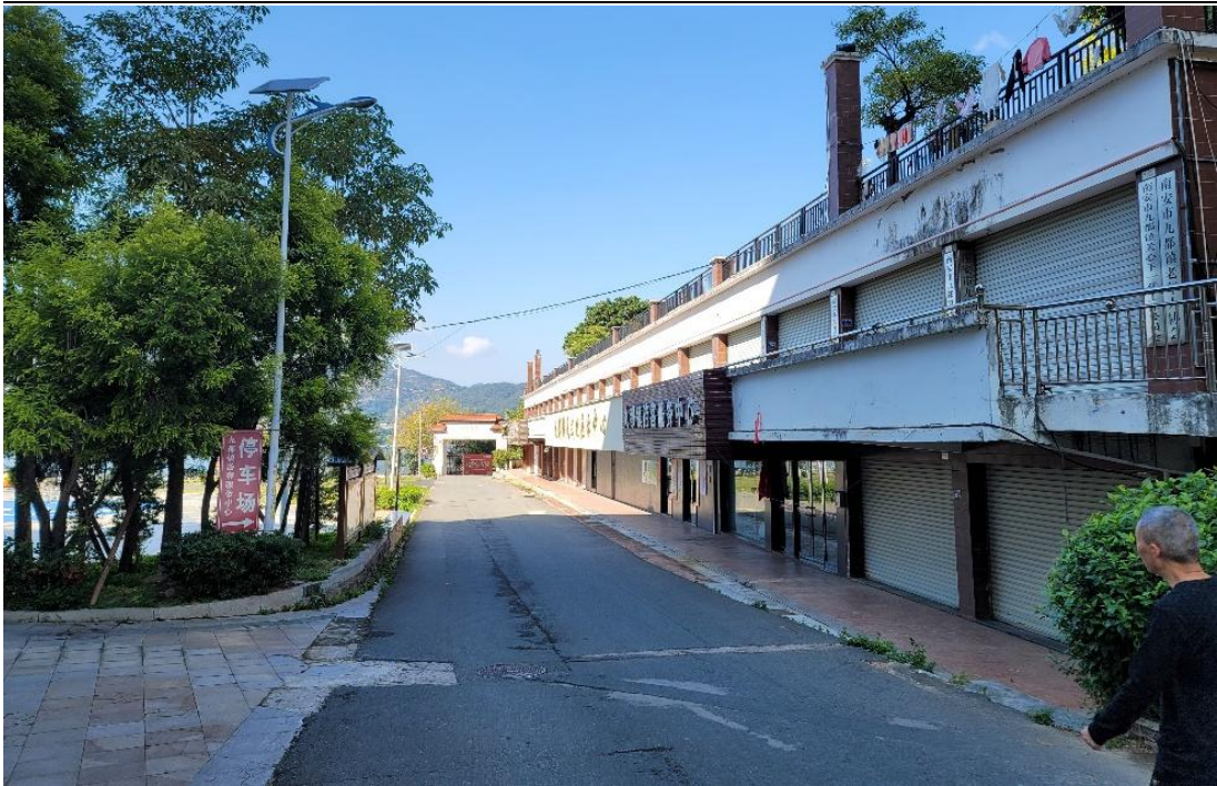
图 3-59 A 段主线沿线路面情况
