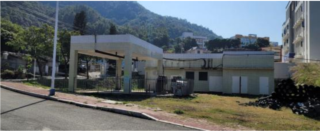
图 3-11 水泵房现场照片
