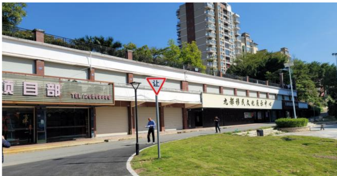
图 3-1 移民文化展示中心立面现场照片
