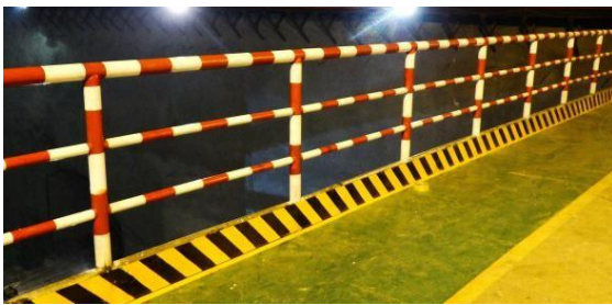
固定式防护栏杆及踢脚板示例
